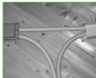
**Einsatz im Ortbeton (Installation auf der Baustelle) und im Fertigteilwerk**
